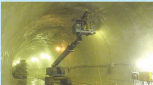
宮城県・鉄道トンネル覆工
